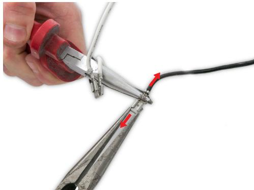
**22** À l'aide de deux paires de pinces à bec long, séparez très soigneusement les fils sous tension et neutres des bornes « Piggyback ».
